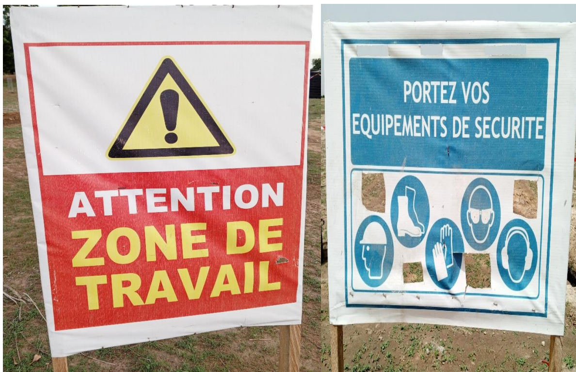
Panneaux de signalisation des travaux
