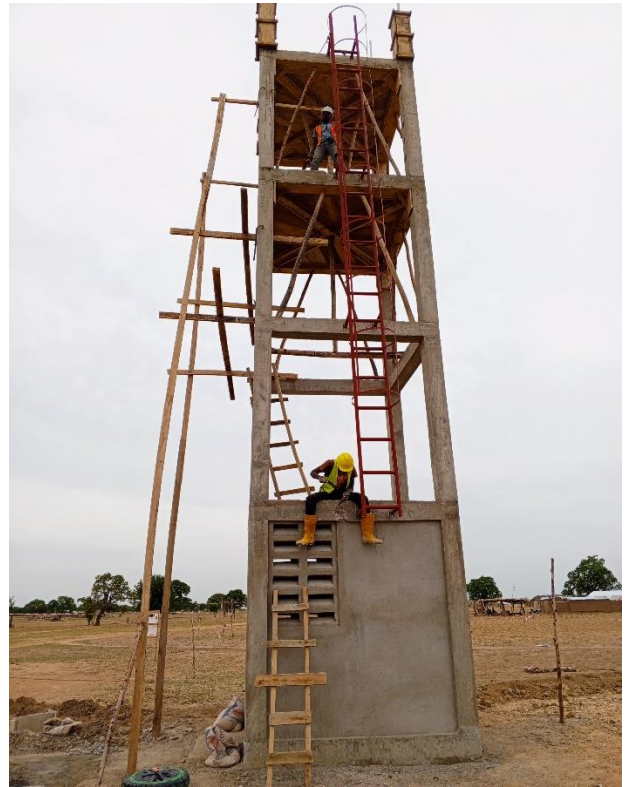
Ouvriers en plein chantier
