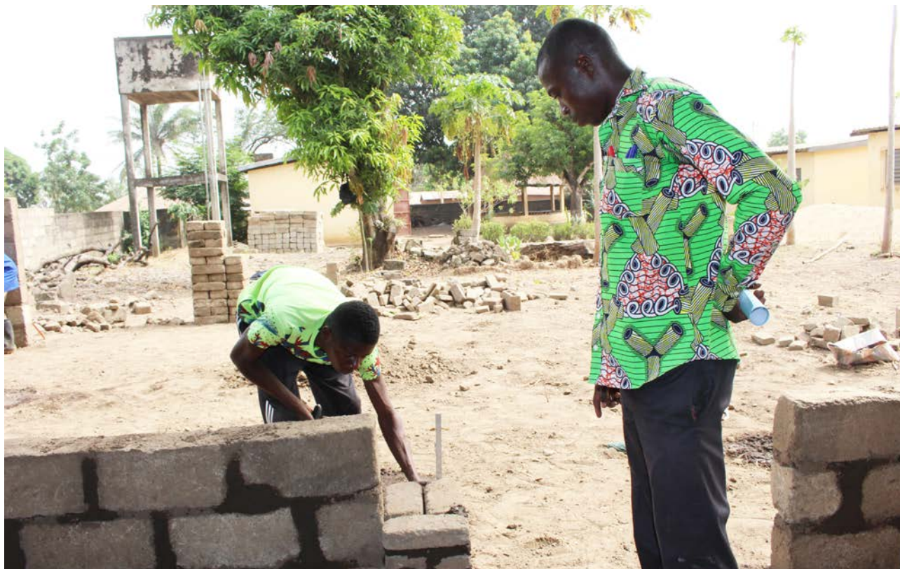
Cours de maçonnerie à l'ITFP
